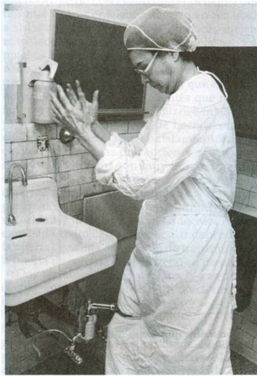
Fig. 24-5. Las llaves (grifos) se consideran muy contaminadas. Por ello la mayor parte de los vertederos de hospitales cuentan con controles que permiten cerrarlas con el pie o la pierna después de lavarse las manos.
