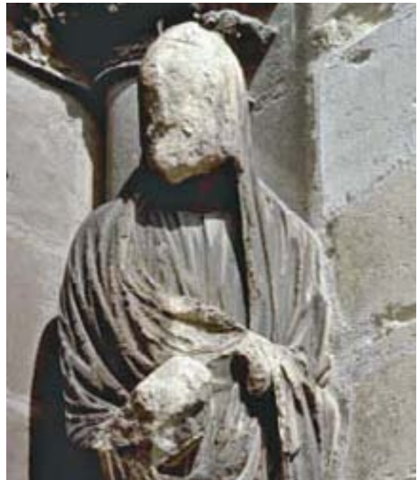
FIGURA 28-13 La sedimentación ácida es corrosiva La sedimentación ácida está disolviendo esta escultura de piedra caliza de la catedral de Rheims, en Francia.
